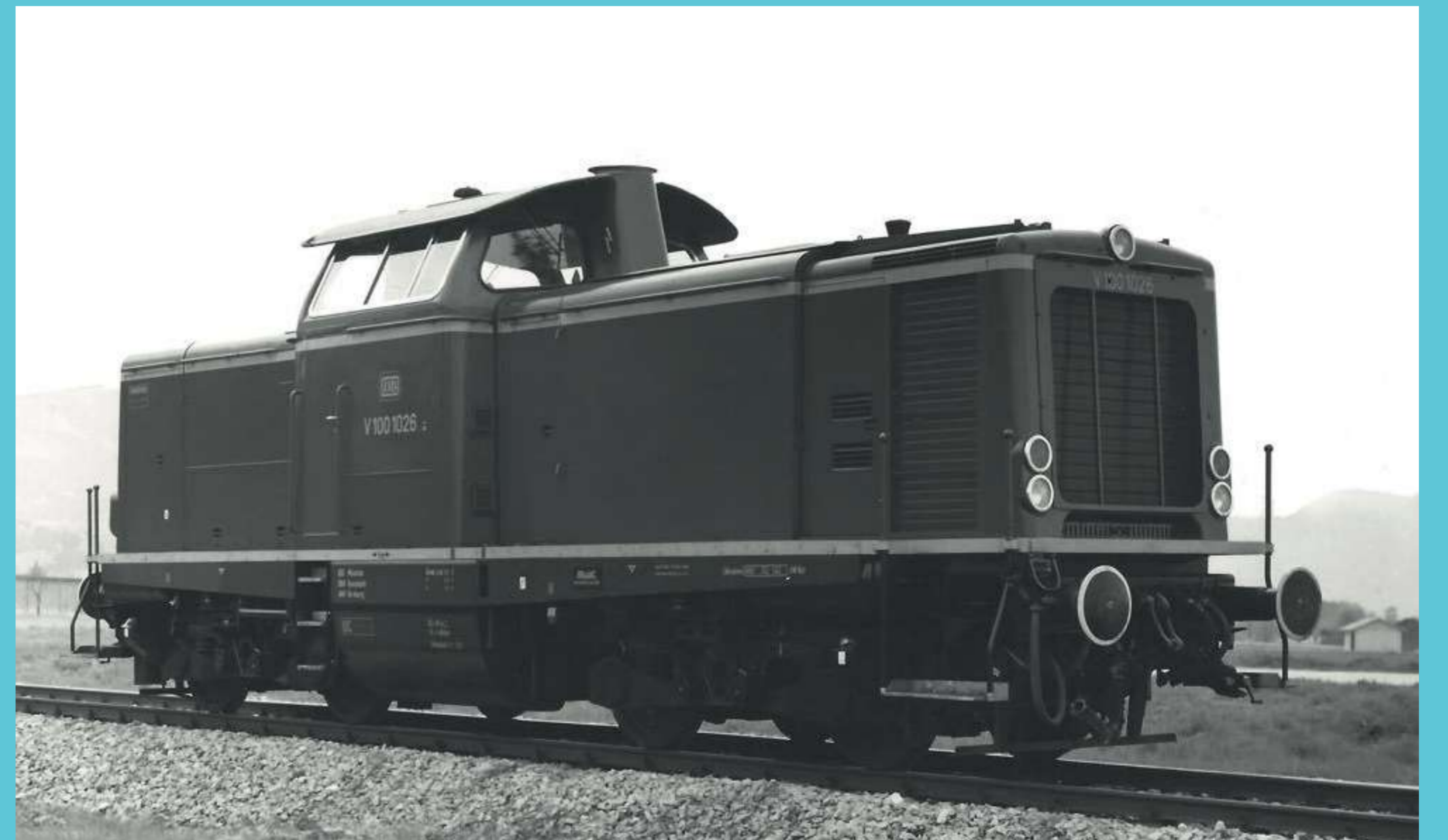
Dieselloks der Baureihe V 100 bedienten Haupt- und Nebenbahnen. Diesel-hydraulic locos of class V 100 worked on both main and secondary lines.
